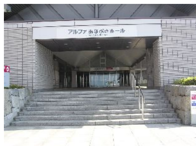
石階段から登った 大ホール棟 正面
