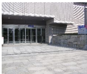
石階段から登った 小ホール棟 正面
